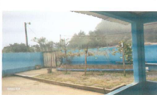
Foto 2: Circulacion de malla con tubo calvanizado del establecimiento. Y porton metalico.
