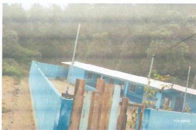
Foto 1: Techo tipo portico y cubierta de lamina calibre 26 troquelada y ciadas de agua pluvial y canales.
