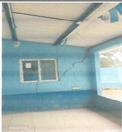
Foto 3: Reparacion de pared de cocina.
